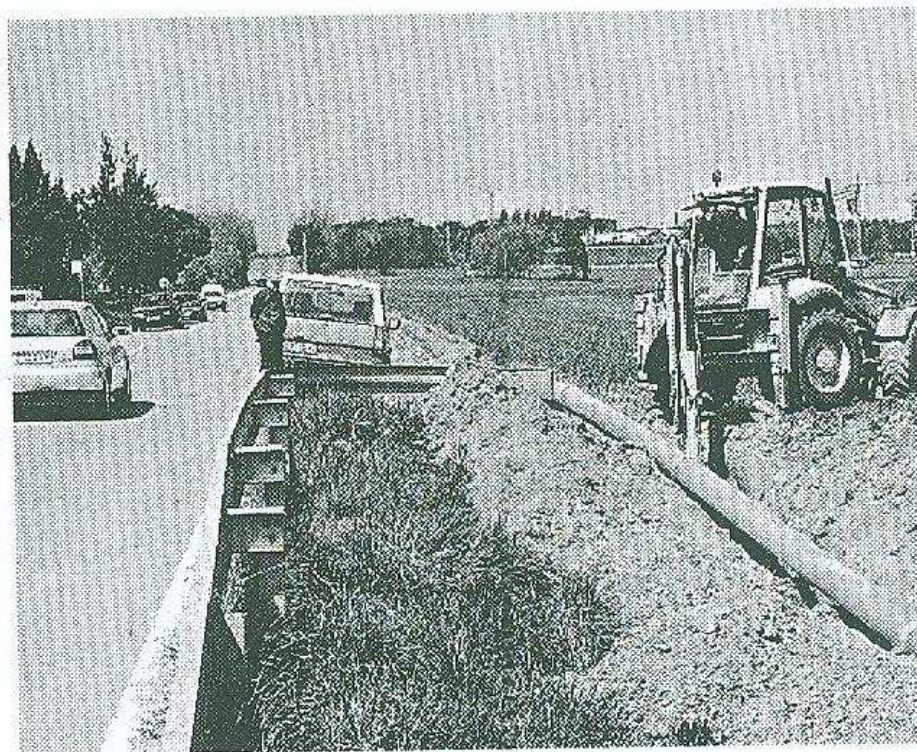
Imatge d'arxiu de les obres del pou de Can Gelabertó. / A.P.
