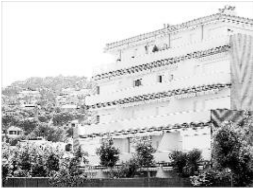
Un dels dos edificis del Llevantí de Mar, que han d'anar a terra.
