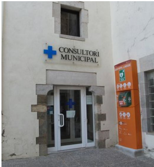
El consultori mèdic d'Aiguaviva està a la part posterior de l'edifici de l'Ajuntament Foto: J.N.
