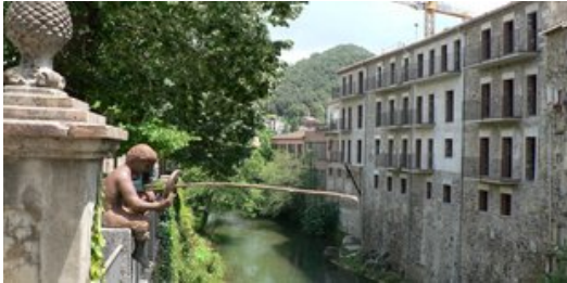
El pescallunes intenta treure quelcom del Brugent, a l'hora que l'acompanyen cases en rehabilitació i grues una imatge inusual a la Catalunya interior. Foto: PAU LANAÓ.
