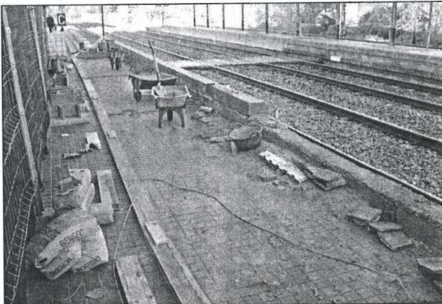
Les obres. Renfe està enlairant l'andana de l'estació de Caldes.
