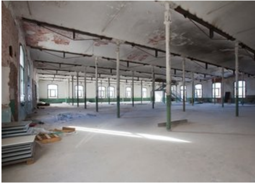
Una imatge de la planta de la Coma Cros de Salt, que serà la seu del centre de la UNED a partir del curs 2013/2014. Foto: EL PUNT AVUI.
