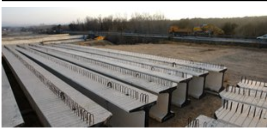
Les obres de l'N-II aturades en el tram entre Sils i Caldes. Foto: LLU S SERRAT.
