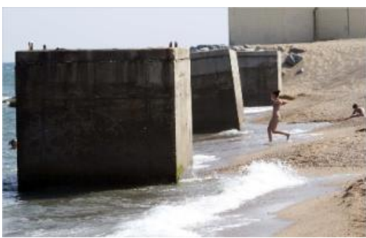
Les plataformes de formigó dels pous de captació encara són presents a la platja de l'àrea de la Tordera.
