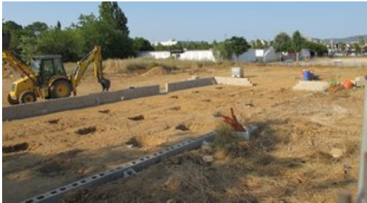
Les obres de la futura escola Pia, al costat del SES Foto: J.N.
