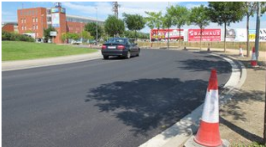
La rotonda de davant l'Espai Gironès ja reasfaltada. Els treballs han continuat la passada nit a l'avinguda de la Pau Foto: J.N.
