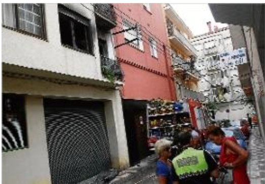
El pis on es va originar el foc a la primera planta va quedar calcinat.
