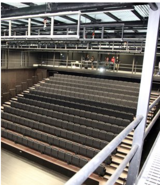
Una vista de la grada retràctil de la sala d'El Canal, desplegada. Foto: JOAN SABATER.
