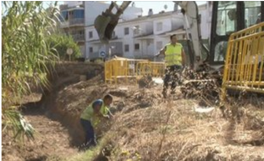
Treballs que ja s'han començat a fer al barri de la Plantera. Foto: AJUNTAMENT DE BLANES.
