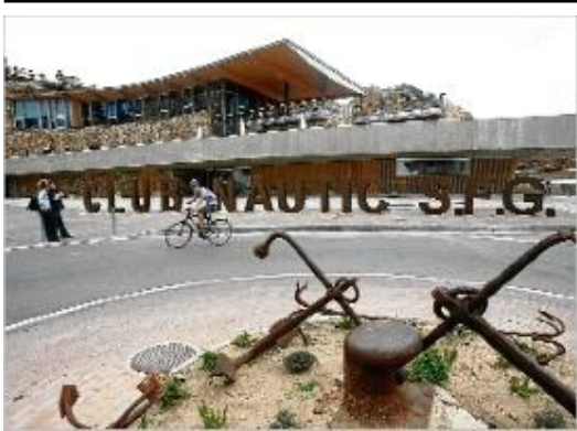
L'Ajuntament ha ordenat clausurar les entrades de la planta intermitja.
