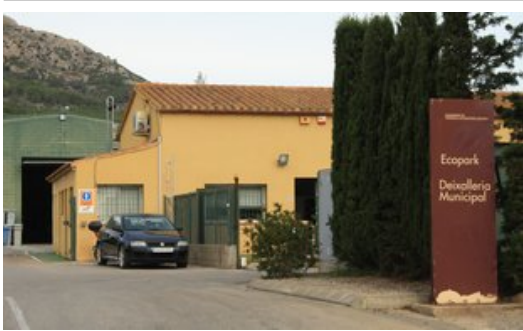
Deixalleria de Torroella - L'Estartit on s'instal·larà la planta de transferència. Foto: J. PUNTÍ.
