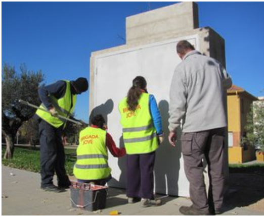
Les brigades joves de Celrà pintant un transformador i treballant amb normalitat. Foto: D.V.
