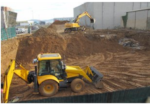
Màquines treballant al solar on anirà la mesquita Foto: J.N.
