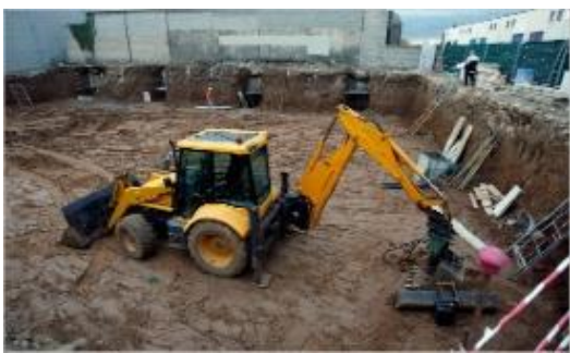
Les obres per a la construcció de la mesquita al carrer Vilablareix.
