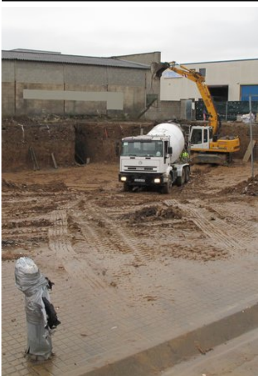
Les obres a la futura mesquita de Torre Mirona Foto: J.n..
