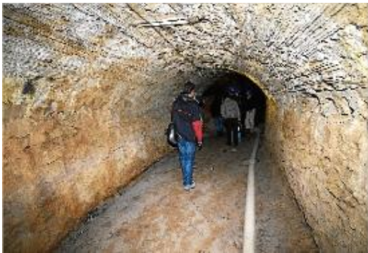
Imatge de l'interior de la mina d'aigua, sota el Palau Lo Mirador.
