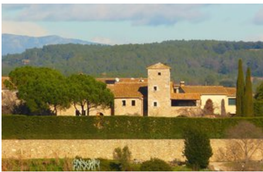
El nucli de Puigpalter de Dalt, on hi ha quatre de les construccions incloses al catàleg. Foto: R. E.
