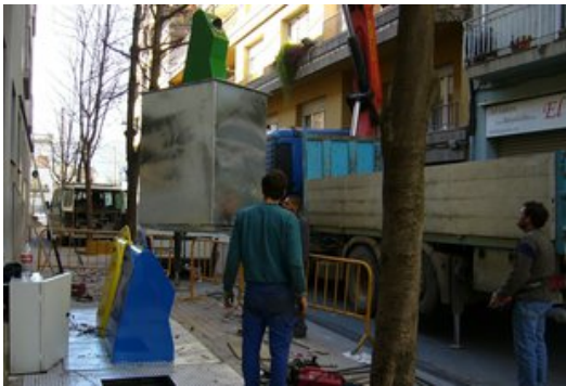
Instal·lació de contenidors soterrats per a la recollida selectiva al carrer del Canat de Banyoles, en una imatge d'arxiu. Foto: R. E.
