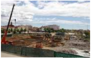
El solar on s'edificarà el Mercadona de Cassà de la Selva, en una foto d'ahir Foto: JOAN SABATER.
