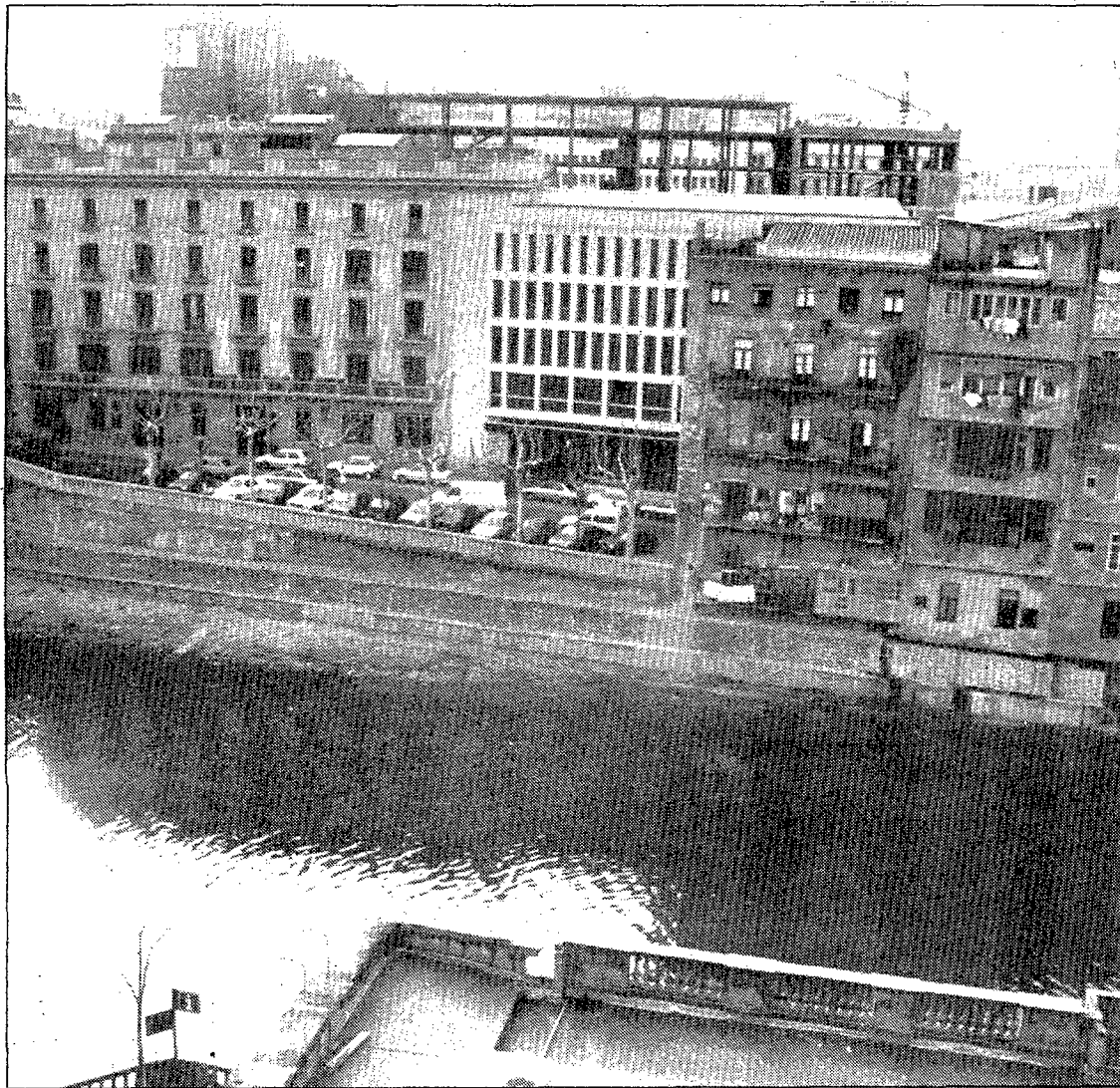
En últim terme, darrera de les primeres edificacions, es pot veure la planta d'àtics que s'ha d'enderrocar. Foto: LLad6.
