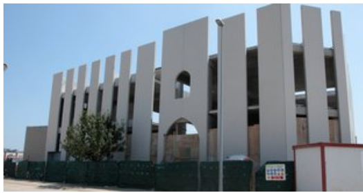
Una imatge exterior de les obres de la nova mesquita de Salt Foto: JOAN SABATER.
