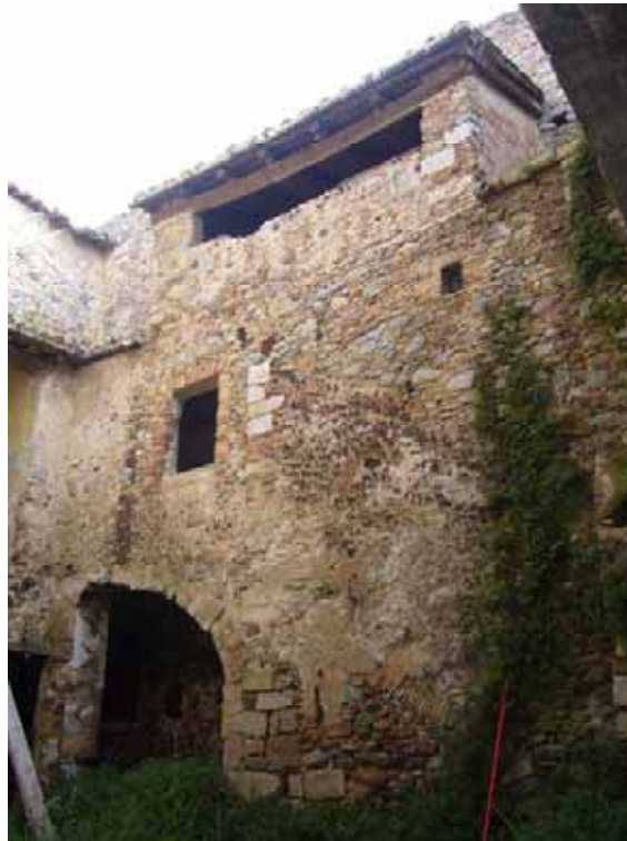
Foto 29: Façana interior Est
