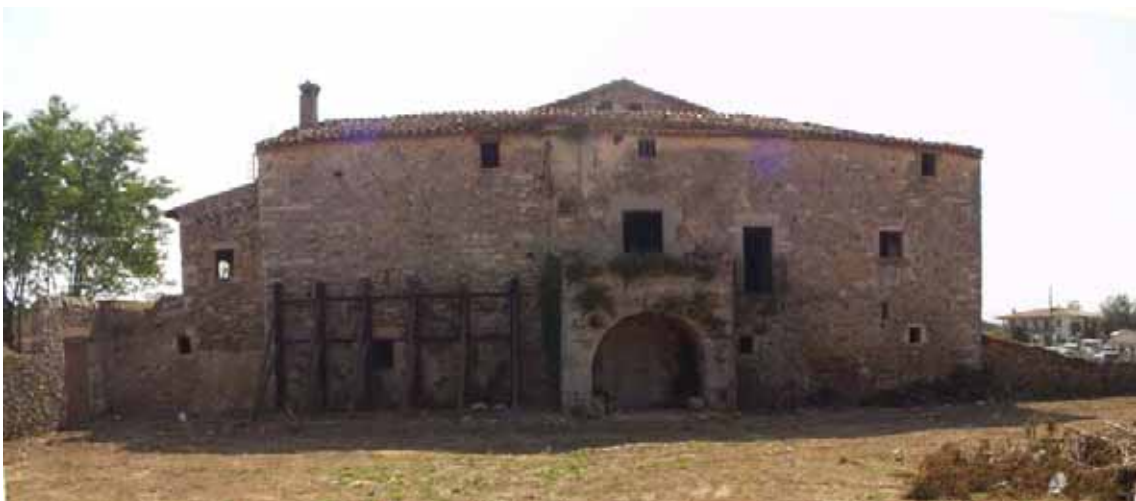
Foto 17: Apuntament de façana
