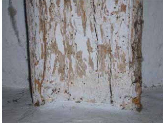
Presència de corcs en bigueta de fusta
