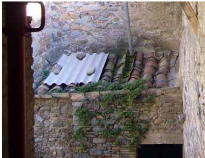
Foto 40: Reparació de coberta amb planxa de fibrociment
