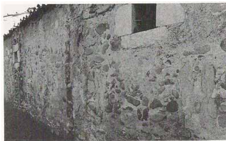
Foto 9. Mur de protecció de l'entrada original del mas. Observeu les espitlleres que el defensaven.
