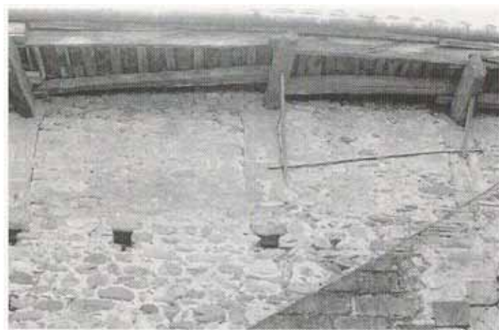
Foto 7. Pilars que marquen una galeria porticada al segon pis, actualment tapiada.
