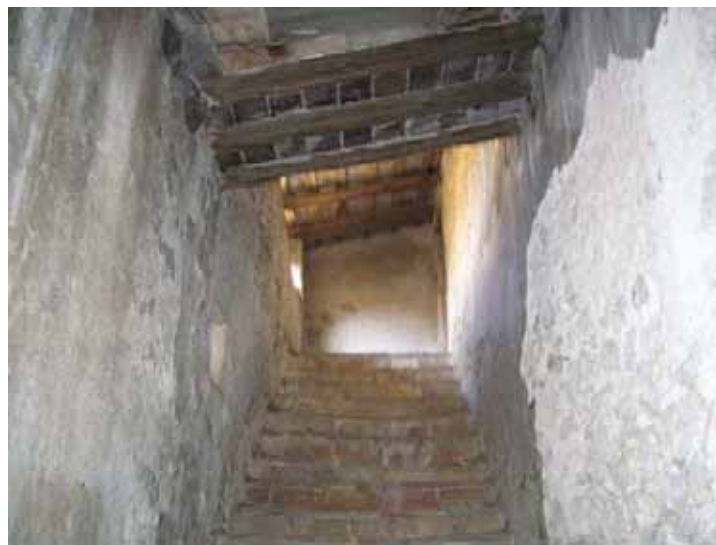
Foto 46: 2on tram d'escala interior vista des de la primera planta
