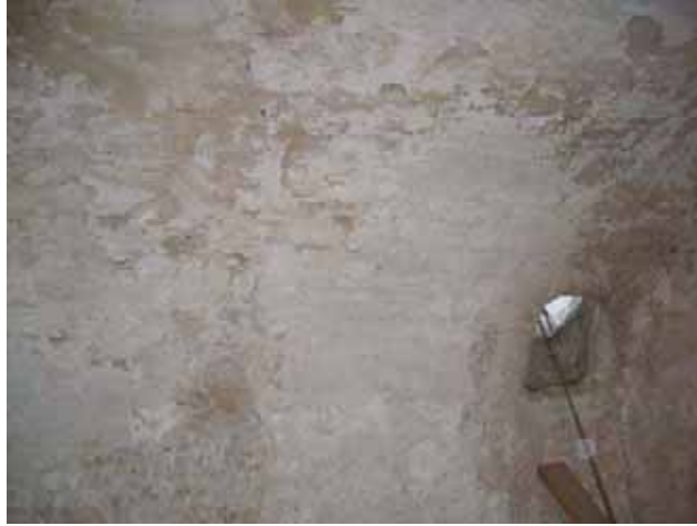
Foto 55: Obertura d'accés a planta 2 a
