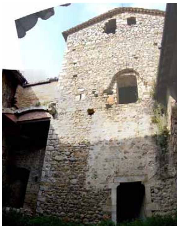
Foto 31,32 i 33: Façana interior Oest
