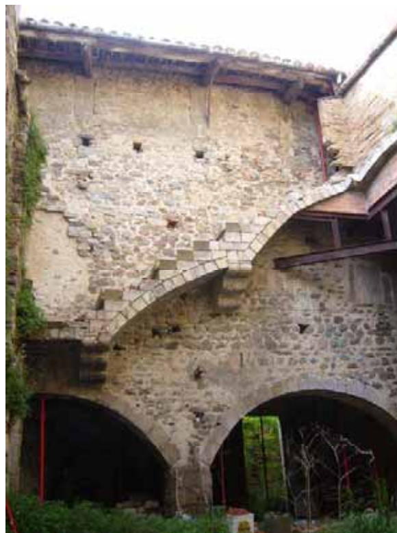
Foto 30: Façana interior Sud
