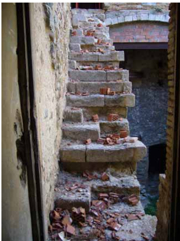
Foto 49: Esclaonat d'escala amb carreus de pedra
