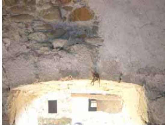
Foto 60: Arc a dovella d'obertura de la torre
