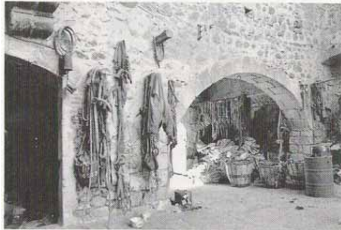
Foto 8. Arcades del edifici meridional que donen al pati interior.
