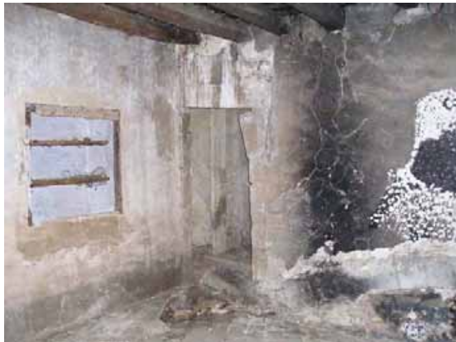
Foto 20 : Obertura apuntalada que separa les dues estances de planta primera.
