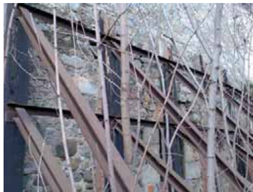
Apuntament de façana est
