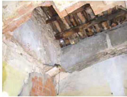
Foto 22: Volta catalana enderrocada.
