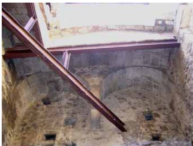
Foto 48: Reforç metàl·lic replà superior
