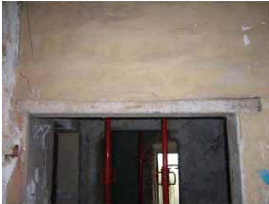
Foto 63: Dintell de fusta en pas interior
