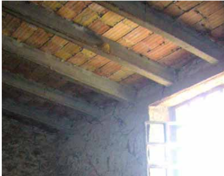
Foto 39: Coberta restaurada amb biguetes de formigó i encadellat ceràmic
