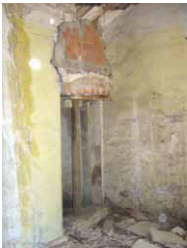
Foto 20 : Obertura apuntalada que separa les dues estances de planta primera.
