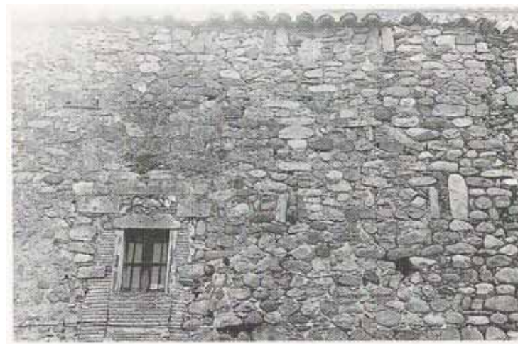
Foto 5. Alineacions d'espitlleres. Podeu veure que el sostre actual inutilitza les espitlleres del segon pis.
