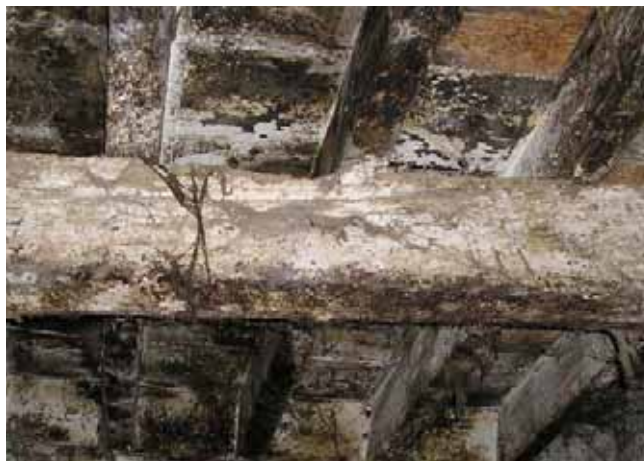
Presència de fongs en sostre de fusta
