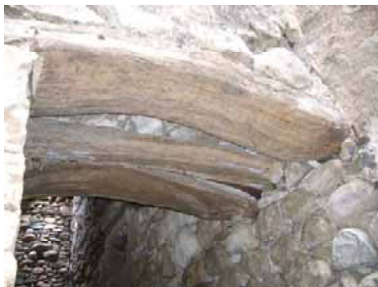
Foto 65: Dintell de fusta a l'exterior
