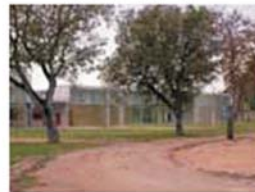
Hospital Sta. Caterina
