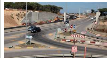
Vista de l'estat actual de l'encreuament on s'ha fer el gran giratori elevat Foto: J. SABATER.
