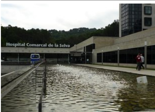
Exterior de l'Hospital Comarcal de la Selva, a Blanes Foto: LLU S SERRAT.
