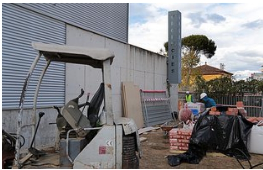
Maquinària situada a l'edifici d'urgències, on es faran els treballs d'obertura d'una nova sala per operar. Foto: MANEL LLADÓ.
