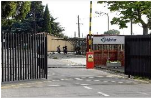
Exterior de les instal·lacions de la planta de Blanes.
