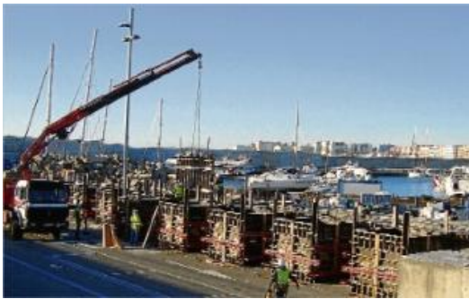
Operaris treballant a Blanes en la construcció dels blocs de formigó per reforçar el dic exterior del Port.
