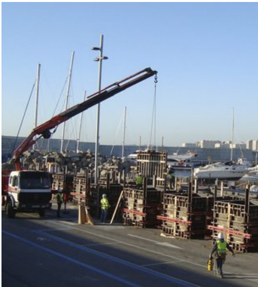
Imatge de les obres, que s'estan fent al port de Blanes Foto: EL PUNT AVUI.
