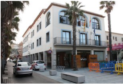
En les partides per a l'any 2014 hi ha una partida de 300.000 euros per a la reforma de l'edifici de l'Ajuntament. Foto: JOAN PUNTÍ.
