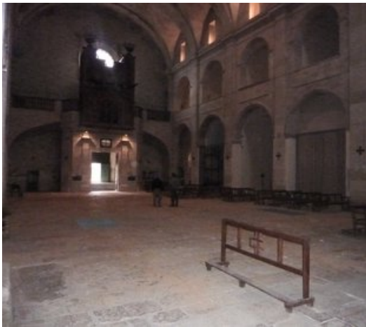
La nau de l'església ahir al migdia, un cop ja havien retirat la setantena de bancs que no s'han pogut salvar. Foto: R. E.
