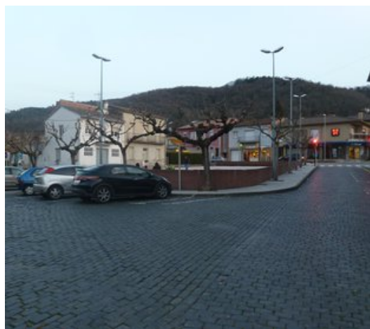
Els carrers de l'entorn de la plaça Major de Sant Joan estan a hores d'ara molt deteriorats. Foto: J.C.
