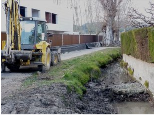
El rec amb un piló de fang quan l'anaven retirant amb màquines com la apareix al costat de la canalització. Foto: R. E.
