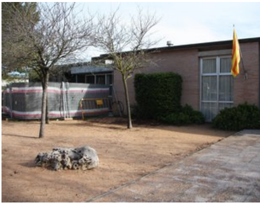
L'escola Alzina Reclamadora de Fontcoberta, en obres. Foto: ACN.
