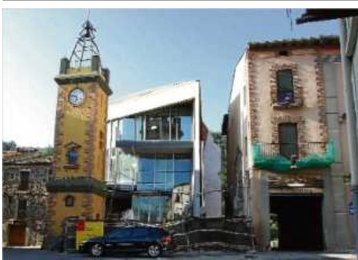
El nou ajuntament, amb les obres parades arran d'una sentència que declara il·legal part de l'edifici.
