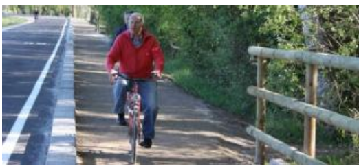
Reobren la carretera de l'Estany de Banyoles amb el nou carril bici
