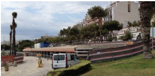
Aspecte de les obres al passeig de la Mestrança de Blanes. Foto: QUIM LLORENS.
