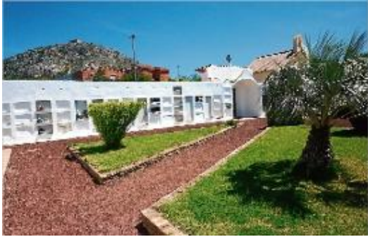
Imatge del cementiri després de la intervenció.
