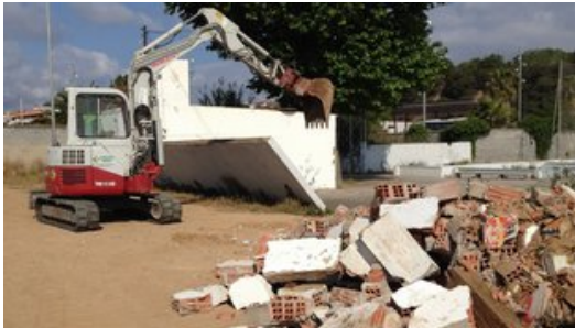
Una imatge dels treballs del començament de l'enderroc del camp municipal dels Pins, ahir al matí. Foto: AJUNTAMENT DE BLANES.
