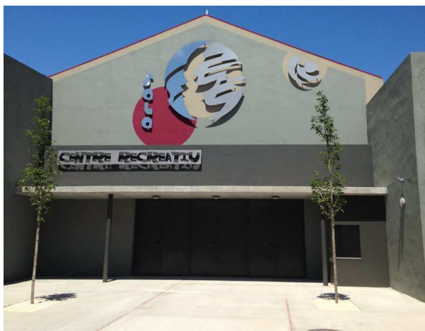
Aspecte de l'entrada de la rehabilitada sala del Centre Recreatiu Foto: EL PUNT AVUI.
