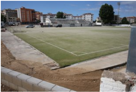
Una imatge del camp del Pins de Blanes, la setmana passada. Al fons, la graderia i els vestidors. La instal·lació serà del tot enderrocada la setmana vinent Foto: LLUÍS SERRAT.
