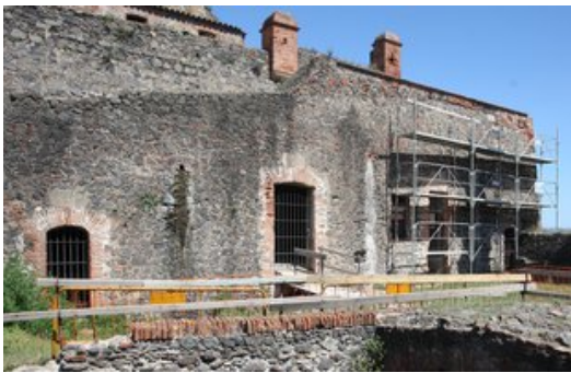
Una imatge de les obres a la rampa de cavallers i a les naus, dimecres Foto: LLUÍS SERRAT.
