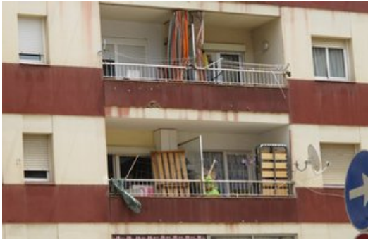
La façana d'un bloc de pisos del centre de Salt, en una imatge d'arxiu. Foto: J.NADAL.
