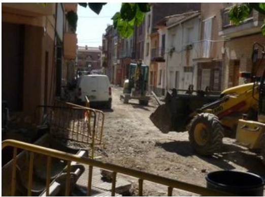
Les obres han començat al carrer Vallespirans, que la setmana passada ofería aquest aspecte. Foto: R. E.
