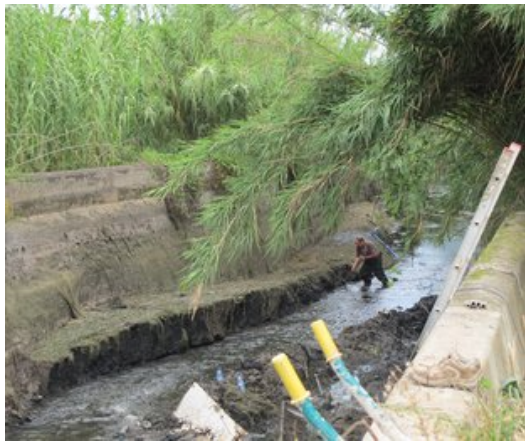
Un operari treballant en la reparació de l'esquerda a la sèquia el 19 d'agost passat Foto: J.N.
