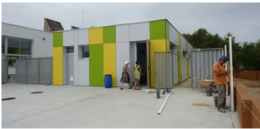
Les noves instal·lacions de l'escola, aquesta setmana, quan encara s'hi treballava. Foto: R. E.
